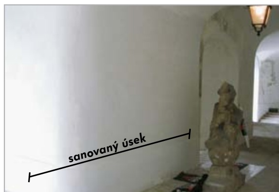
po sanaci systémem Seccopor
